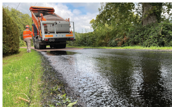
La commune de Saint-Julien-de-Civry a bénéficié de la pose d'un nouvel enduit sur plusieurs sections de voirie par Le Grand Charolais en 2024.
